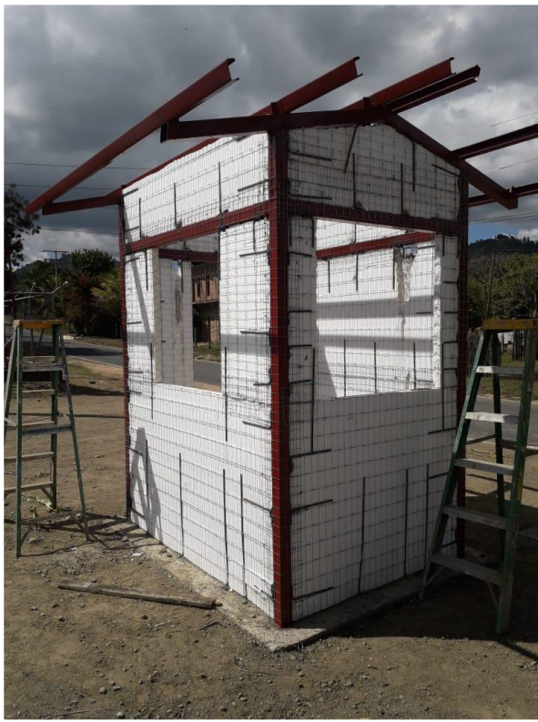
CONSTRUCCION DE CASETA DE VIGILANCIA
