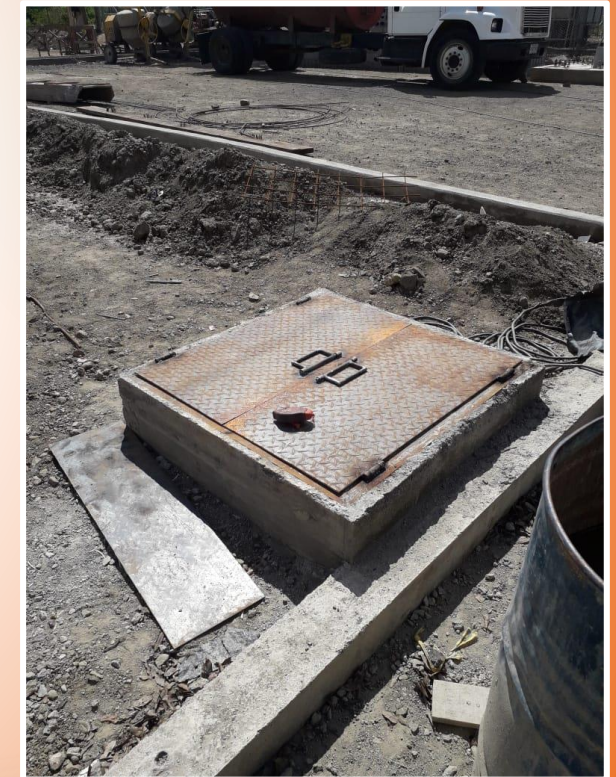
COLOCACION DE LAMINA ANTIDERRAPANTES EN CAJAS DE REGISTRO
