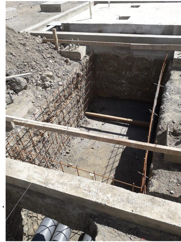
COLOCACION DE HIERRO EN CANALETA
