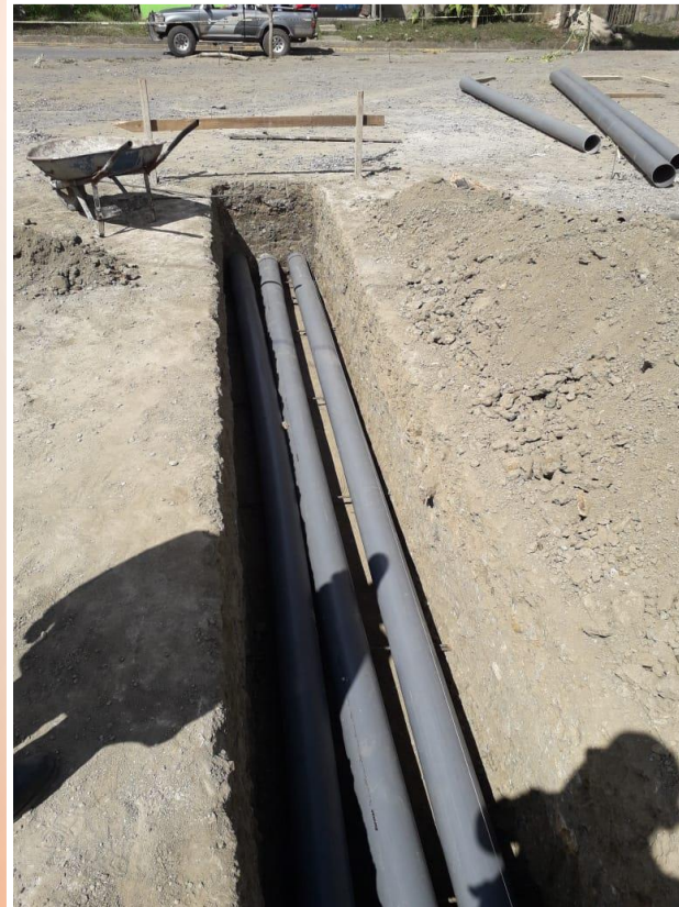
COLOCACION DE TUBERÍA EN DUCTO
