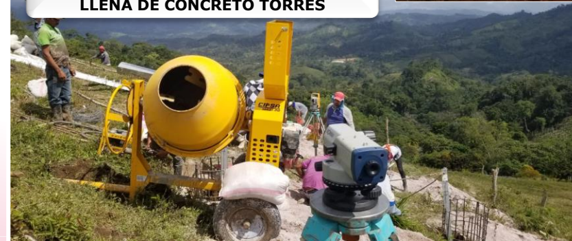
LINEA LA DALIA-WASLALA LLENA DE CONCRETO TORRES
