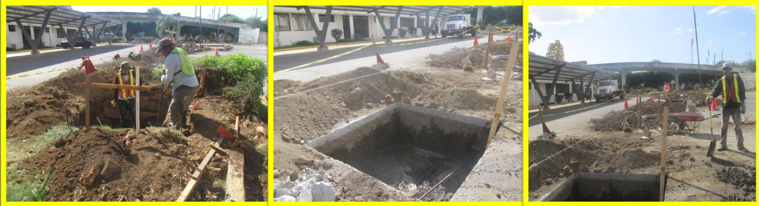
Construcción de bases de estructuras de soporte en el parqueo para la instalación de 357 paneles solares y 133 paneles en estructura de techo en edificio administrativo, para un total de 490 paneles de 171.5 kWp c/panel lo que hace un total de 172 kWp. (9kWp de respaldo de lo contratado que son 162kWp).
