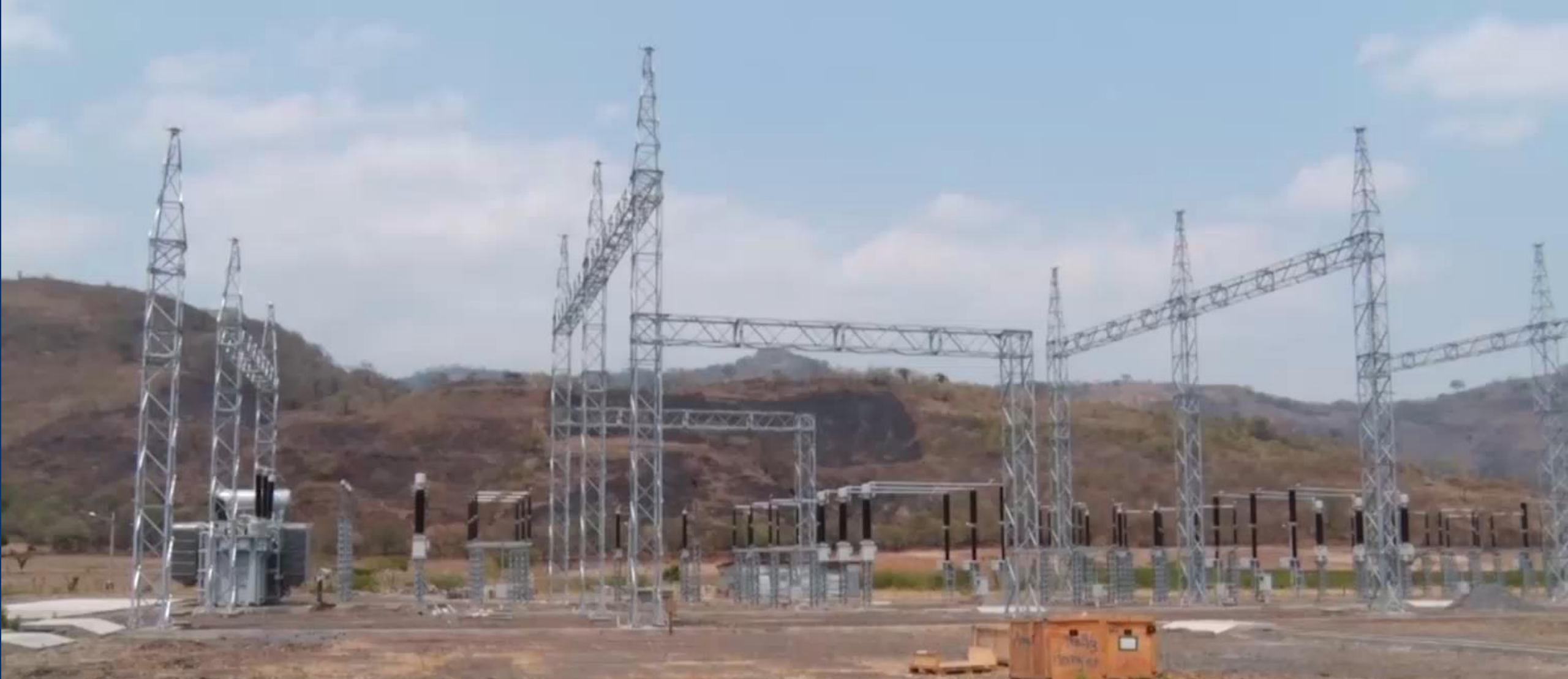
Avances ampliación Subestación Gracias a Dios (Terrabona)
