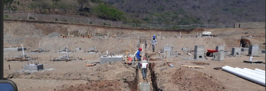
Llenado de losa fondo de canaleta.
