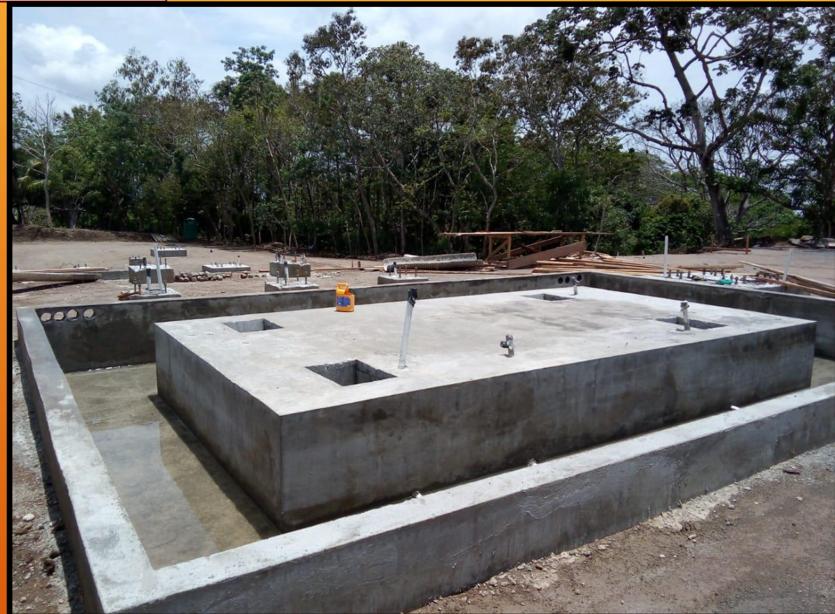
LLENA DE BASE PARA TRANSFORMADOR DE 15 MVA
