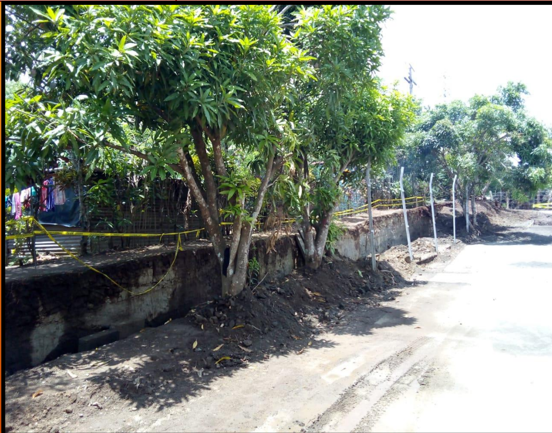
CONSTRUCCION DE MURO MIXTO PERIMETRAL
