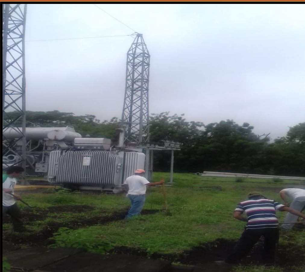
TRABAJOS PREVIOS A LA INSTALACIONES DEL TRANSFORMADOR DE POTENCIA
