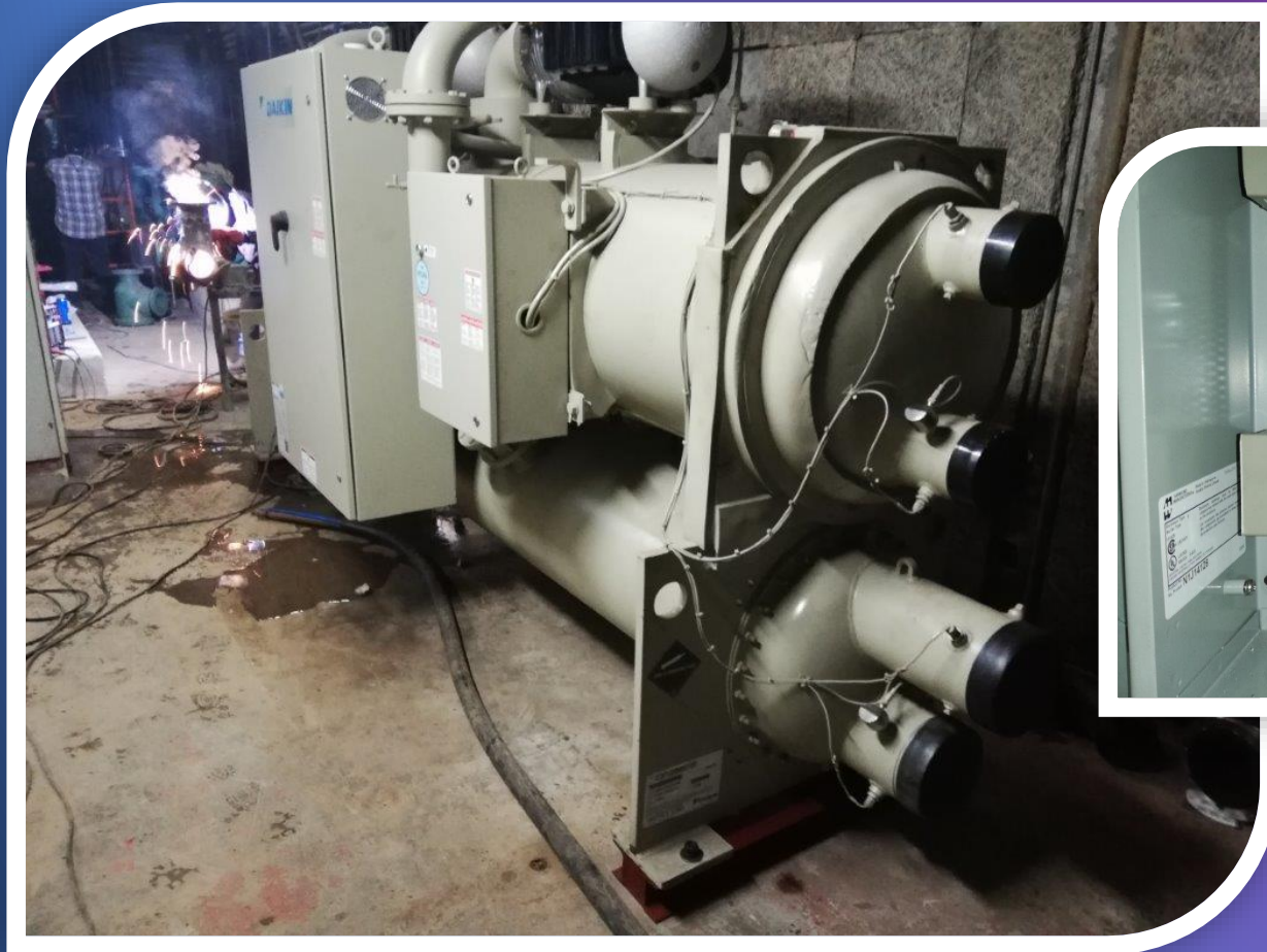
TRABAJOS EN LA TUBERIA DE AGUA DEL CHILLER No. 2
