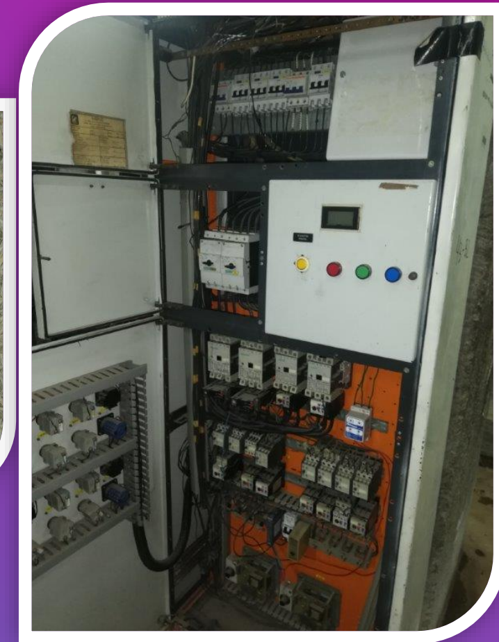
INSTALACION DE GABINETE DE CONTROL DE MANEJADORAS
