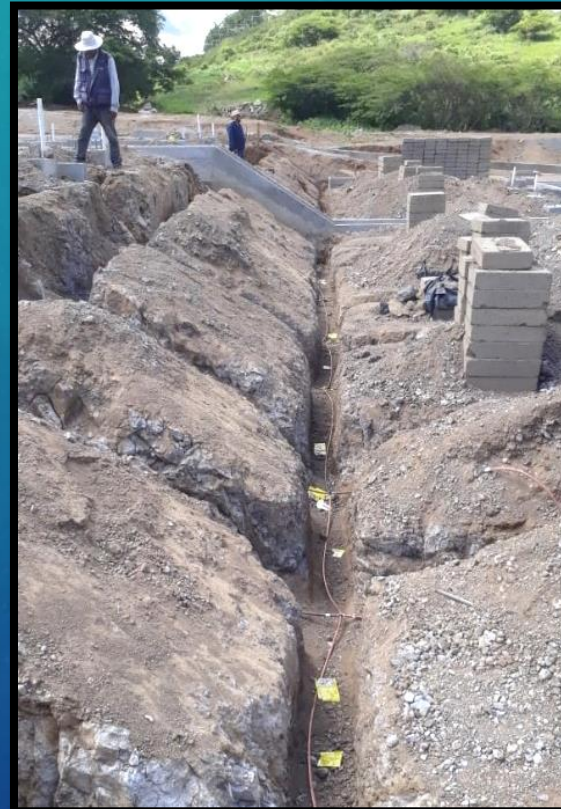
Instalación de Red de tierra
