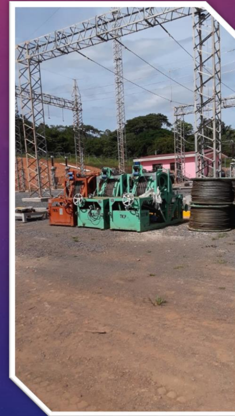
Cables para el tendido
