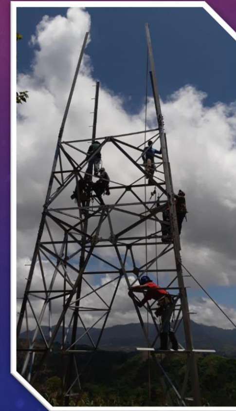
Armado de torres
