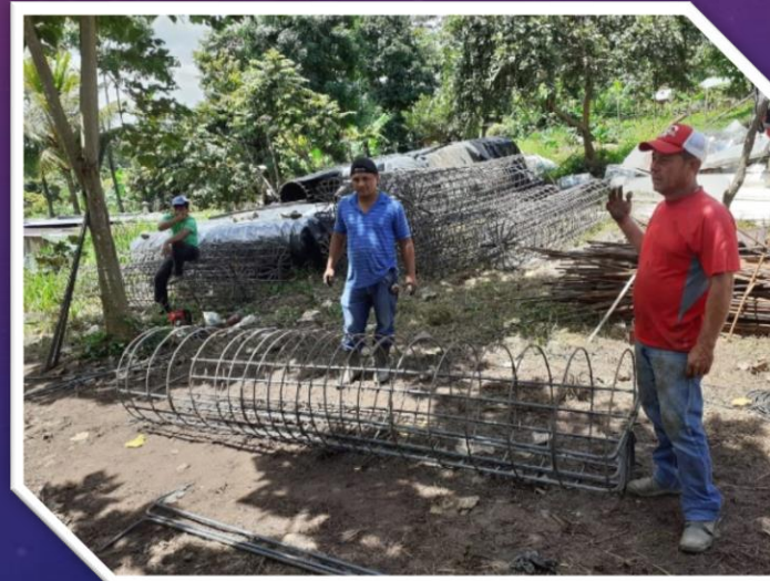
Alistado y Armado, acero de fundaciones de torres #41,131,119.
