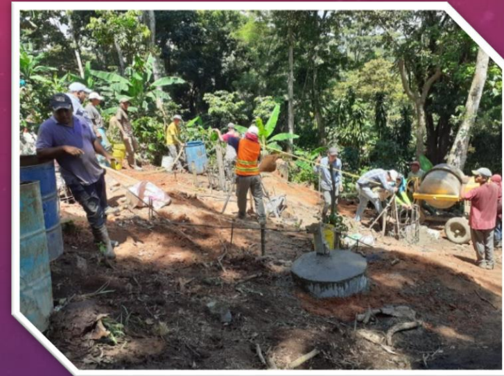
Colado de fundaciones torre #139
