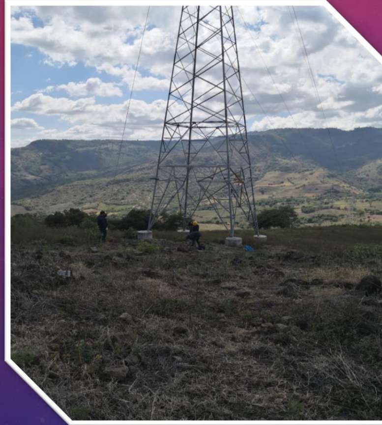
Preparación de estructura de suspensión para su engrape
