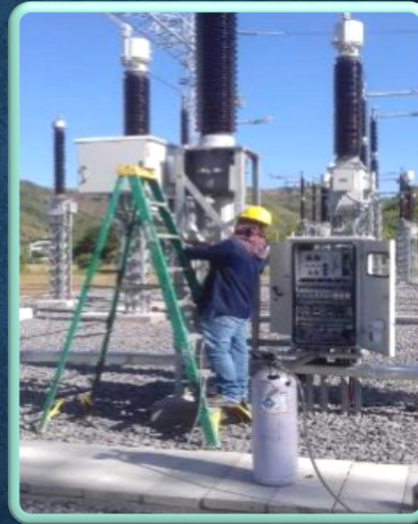
Relleno de SF6 a interruptores 230 kV.
