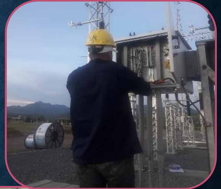
Conexión de cables de control a interruptores de potencia de 230 kV.
