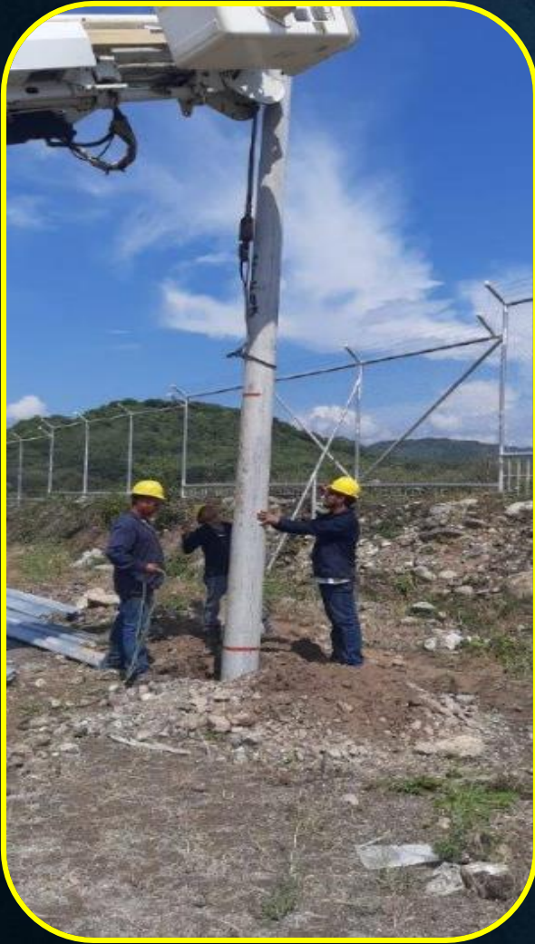
Instalación de postes para el alumbrado perimetral.
