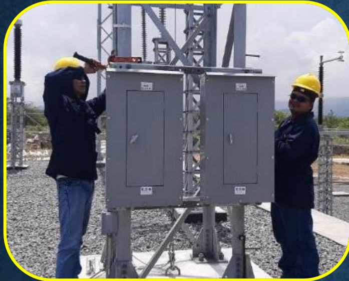
Instalación de paneles para el alumbrado en nuevas bahías de 230 kV.
