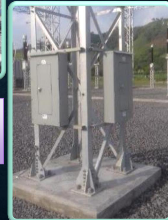
Montaje de panel de control para el alumbrado exterior.
