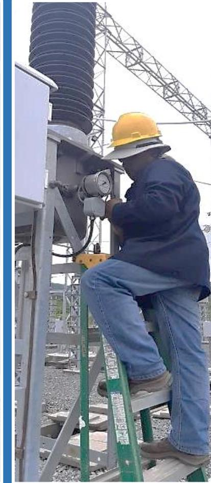
***OBRAS ELECTROMECANICAS:*** Pruebas de mecanismo y ajustes de Seccionadores de las nuevas bahías de 230 kV.
