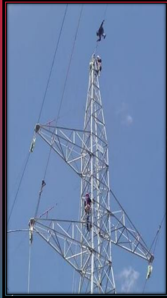
Tendido de Línea
