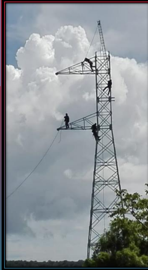
Montaje de estructuras de celosía
