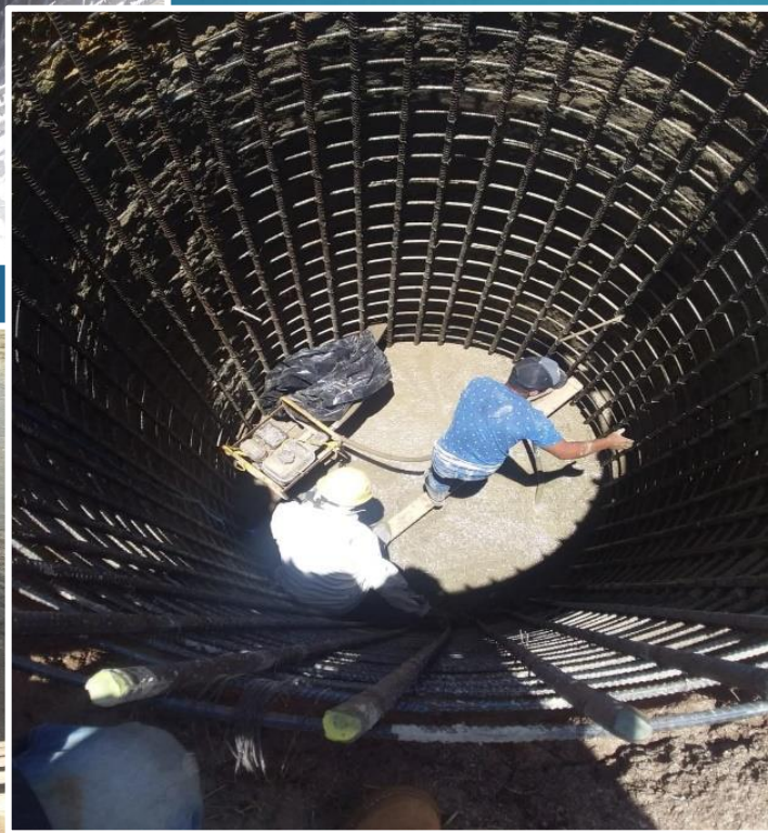
ARMADO DE ACERO PARA FUNDACIÓN DE POSTE
