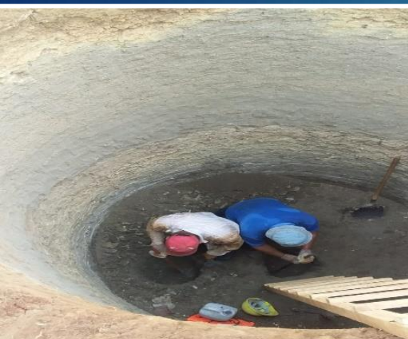
EXCAVACIÓN DE BASE PARA POSTES
