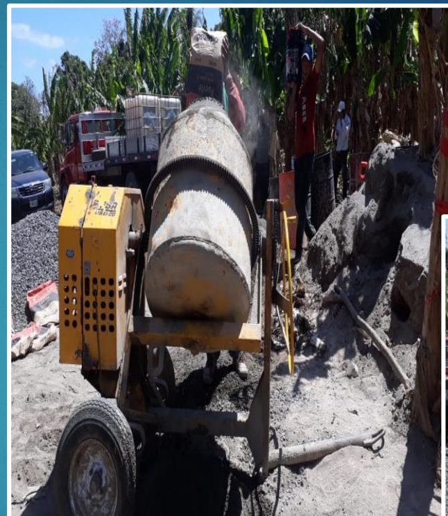
COLADO DE CONCRETO PARA FUNDACION DE POSTES
