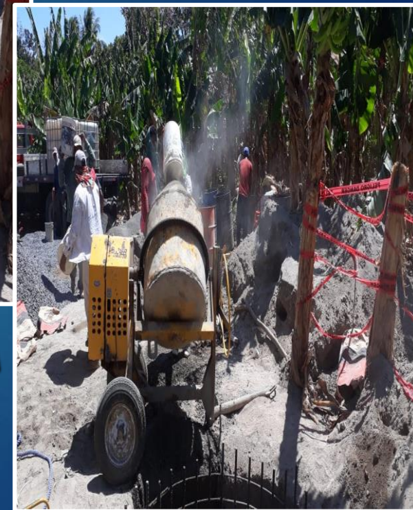
COLADO DE CONCRETO PARA FUNDACION DE POSTES
