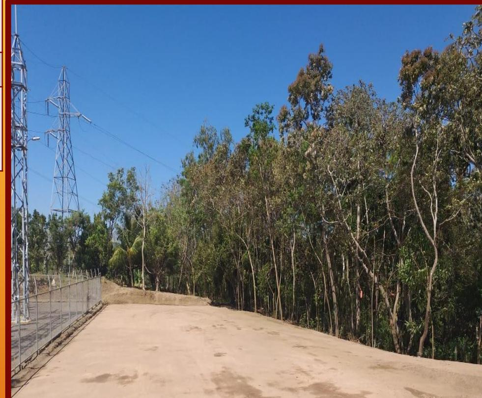
**SE REALIZO MOVIMIENTO DE TIERRA , SE DARÁ INICIO CON EL REPLANTEO TOPOGRÁFICO DE FUNDACIONES PARA LA BAHÍA.**
