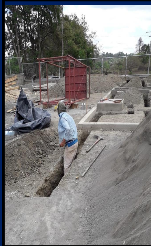
Excavación red de tierra
