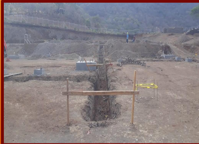
EXCAVACIONES PARA DRENAJE Y CANALETAS
