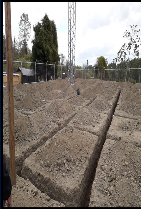
Excavación red de tierra
