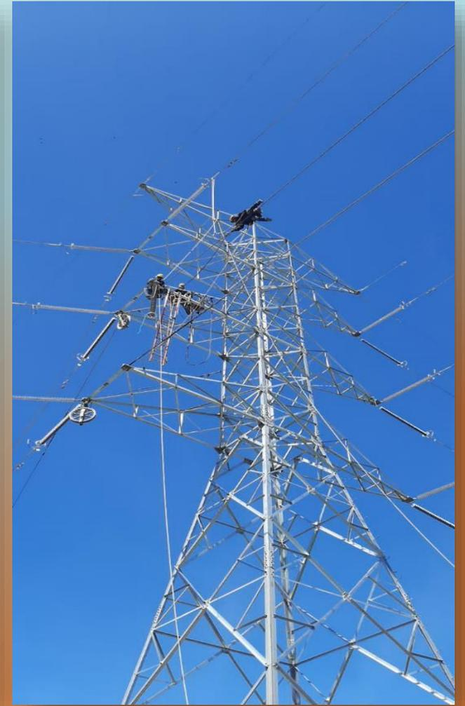
**Flechado de tres fases de conductor ACAR 1024 MCM de la torre #4 al poste #12 pertenecientes al circuito II, realización de amarres de suspensión de fibra óptica y conductor en el poste #13, para la construcción del tramo de línea de la EPR**
