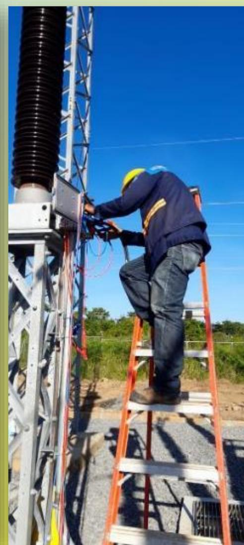
**Pruebas eléctricas (resistencia de aislamiento) a transformadores corriente en bahías de 230kV, proyecto EPR en subestación La Virgen**
