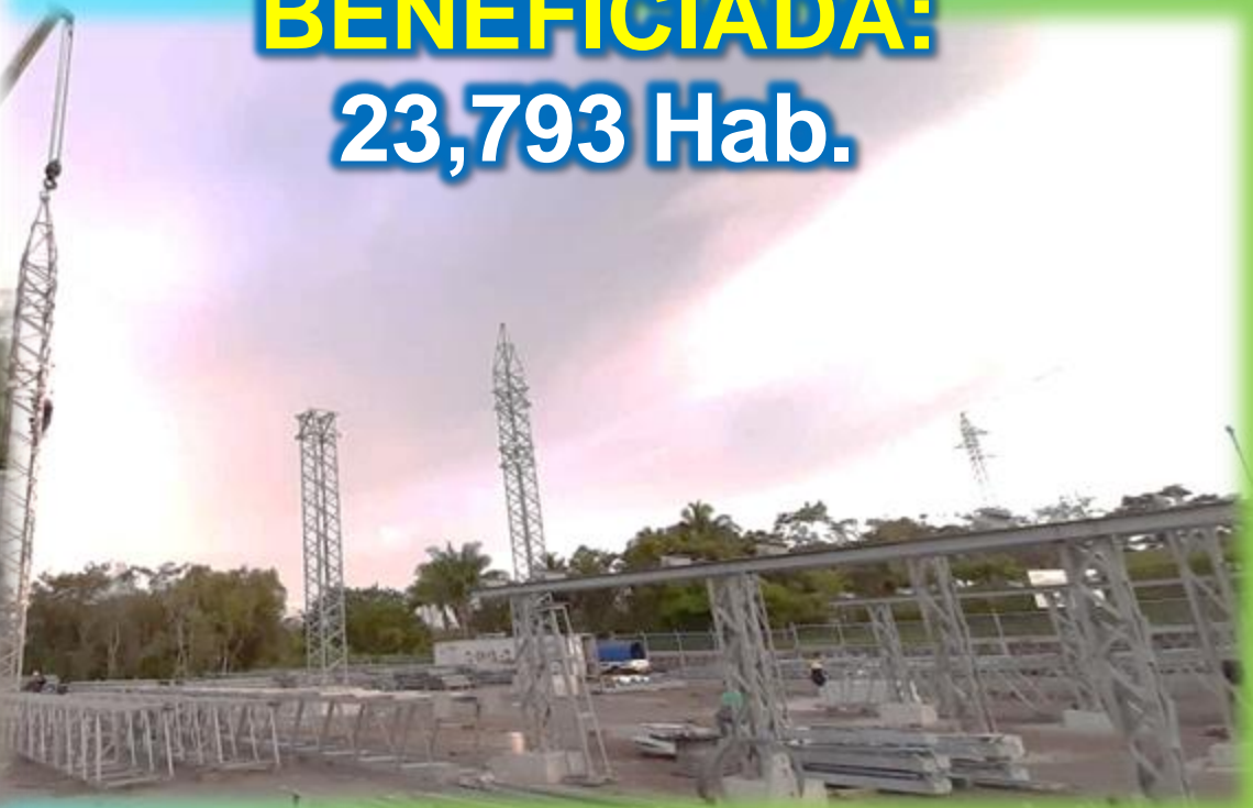
Trabajo de montaje en la subestación
